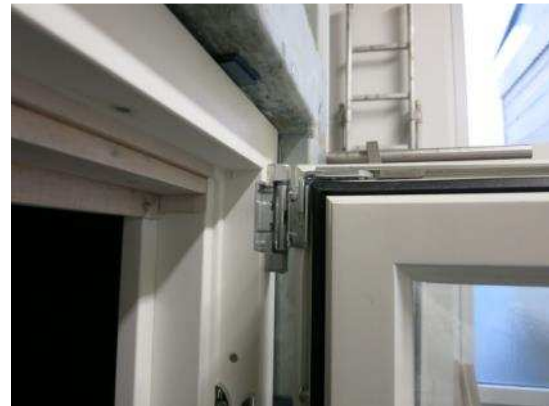
Bild 7 Scherenlager, Falzansicht
