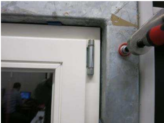
Bild 6 Scherenlager, Innenansicht
