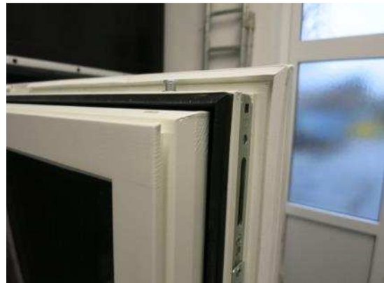
Bild 3 Flügelrahmen, Eckausbildung
