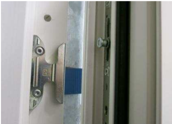
Bild 12 Verriegelungssituation Blend- und Flügel- rahmen 1
