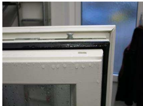
Bild 5 Falzansicht Flügelrahmen
