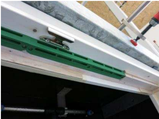
Bild 20 Falzlüfter in eingebautem Zustand, Variante 3 DOUBLE
