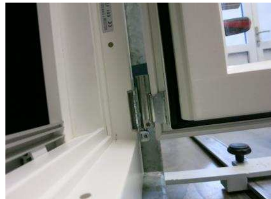
Bild 9 Ecklager, Falzansicht
