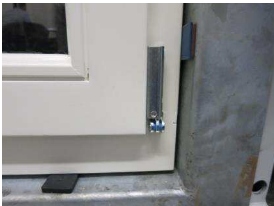
Bild 8 Ecklager, Innenansicht
